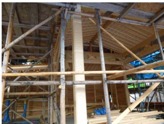
目付柱付近より能舞台を見る
