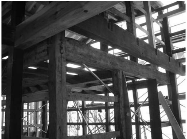
古在を使い、足りない部分は新しい木材を使用
